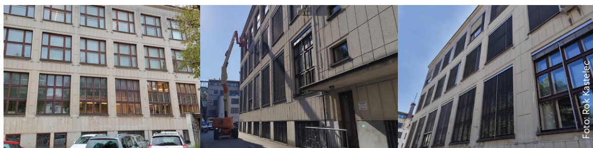
Namestitev žaluzij na severni steni stavbe.
