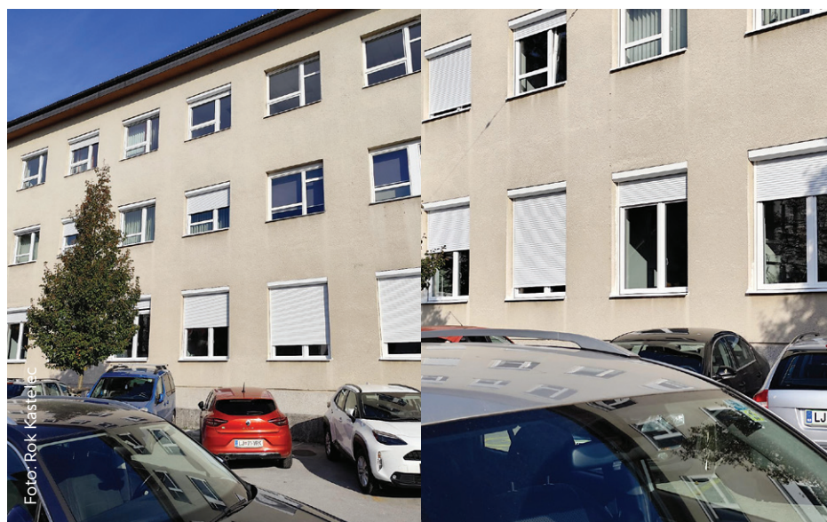
Stavba na Lepem potu 11 z novimi okni.
