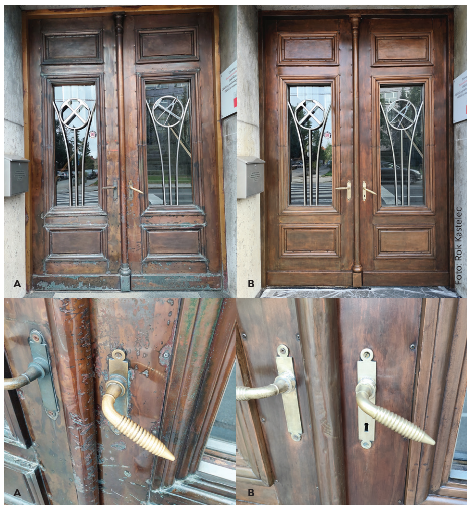
Vhodna vrata na Aškerčevi A) pred in B) po izvedbi restavratorskih del.
