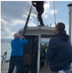
Dela na višini
