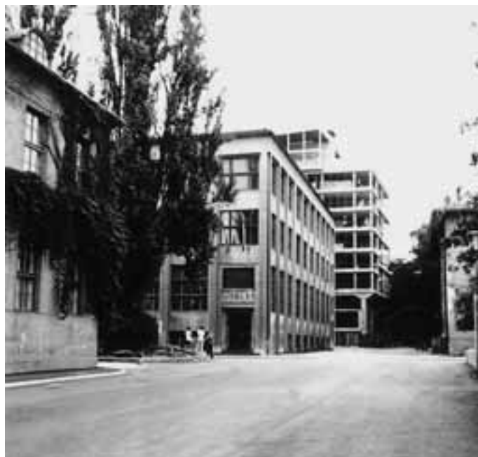
Poslopje strojnega oddelka, ki je bilo dokončano leta 1946, za njim novo poslopje v gradnji, v ospredju vzhodni trakt Stare tehnike. (Zgodovinski arhiv in muzej Univerze v Ljubljani, Ljubljana.)
