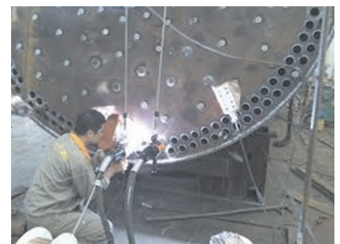
Varjenje parnega kotla
