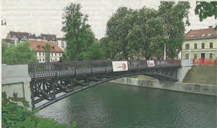
HRDECKEGA MOST NA NOVI LOKACIJI OB IZLIVU GRADAŠČICE V LJUBLJANICO MAJA LETOS FOTO GREGOR PUCELJ
