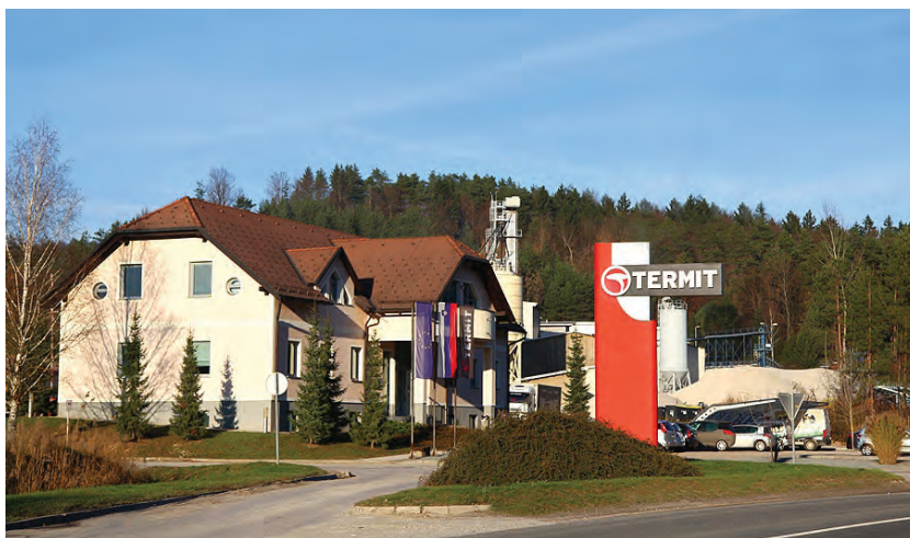
Slika 23: Termit Moravče z novo oplaščevalnico
