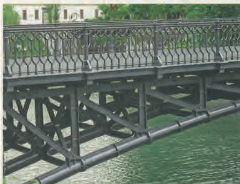
DETALJ »NOVEGA« MOSTU – Nosilno konstrukcijo tvorijo le trije nosilni loki iz cevi, ojačenih z vzdolžnimi in prečnimi rebri. Tako je dosežena manjša teža mostne konstrukcije, ki je spojena z vijaki. Na cevnih lokih slonijo posamezni trikotni elementi, uliti v enem kosu, kar je bila pomembna novost. FOTO GREGOR PUCELJ
