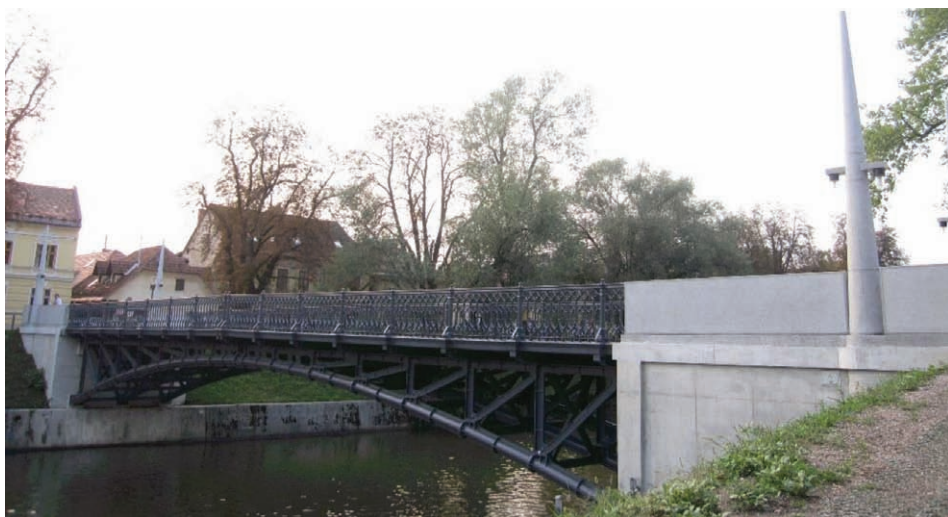
Litoželezni Hrdecke most povezuje Trnovo in Prule (vir: Wikipedija)
