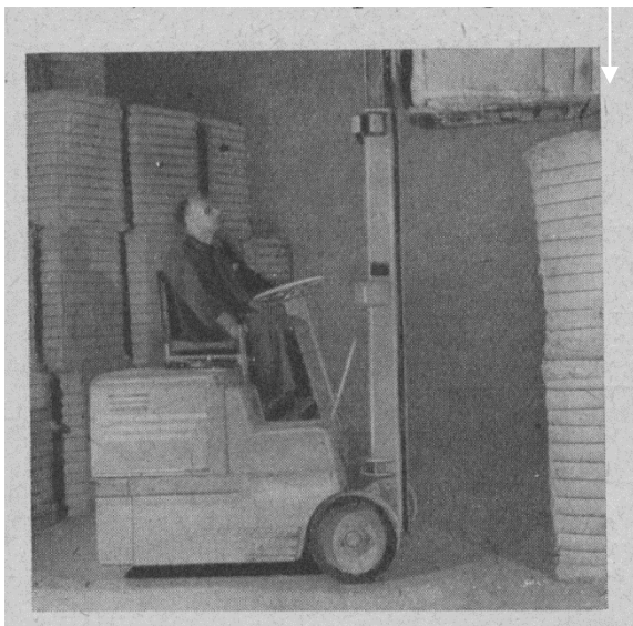
Slika 3.3: Transport bali z viličarjem 1- viličar 2- dviganje bale s pomočjo premičnega teleskopskega droga z vilicami 3- polaganje bale v lotu
